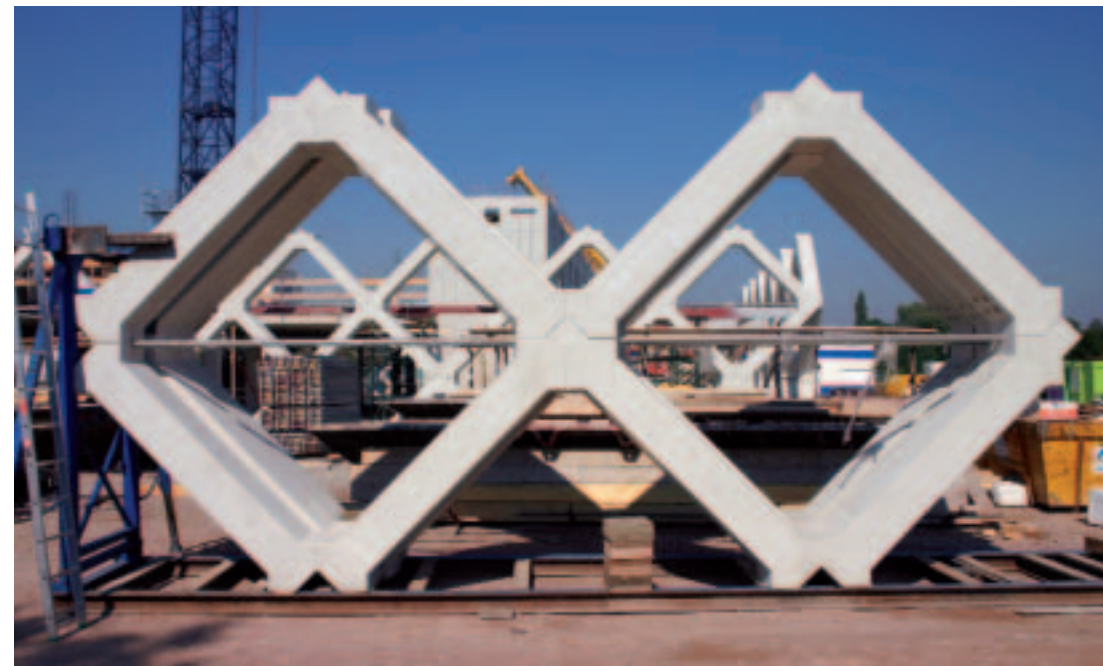
Opslag op de bouwplaats.
