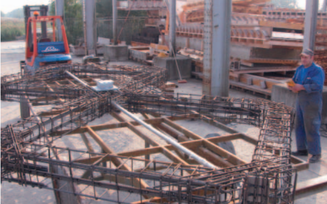
Wapeningproductie voor prefab element.
