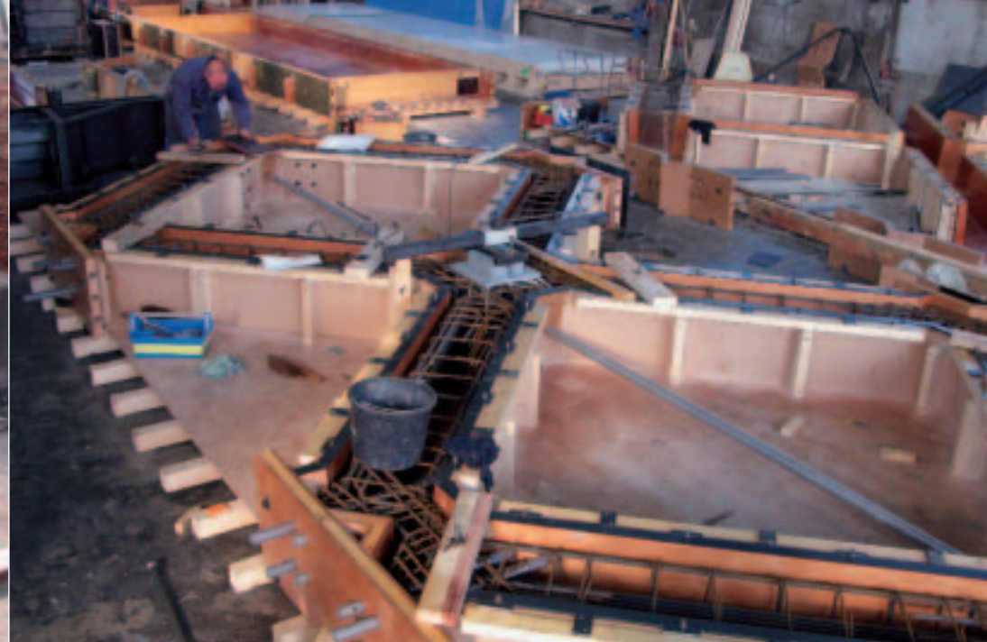
Bekisting voor prefab element.
